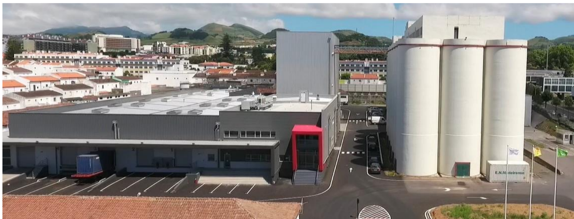
Unidade industrial de Ponta Delgada:
